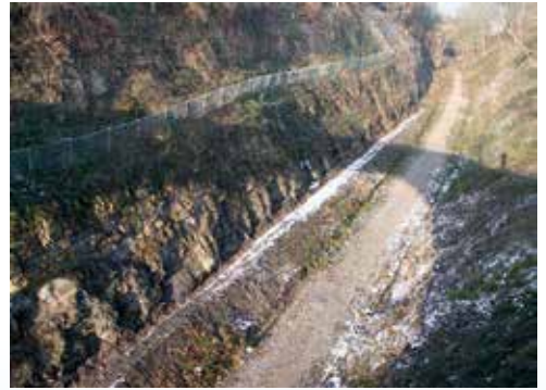
Der weitgehend fertiggestellte Radweg von der Brücke Höltkenstraße in Wengern
