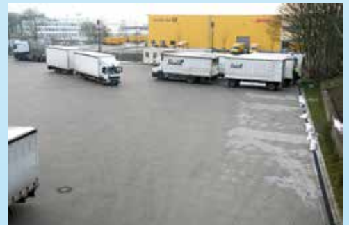
Das Gewerbegebiet auf dem Gelände des ehemaligen Bahnhofes Schwelm-Loh von der Brücke Prinzenstraße aus. Im Vordergrund sieht man die Erweiterungsfläche der Spedition Schmidt-Gevelsberg, dahinter das DHL-Verteilzentrum. Rechts im Bild sieht man die Stützmauern der ehemaligen Bahnanlagen.
