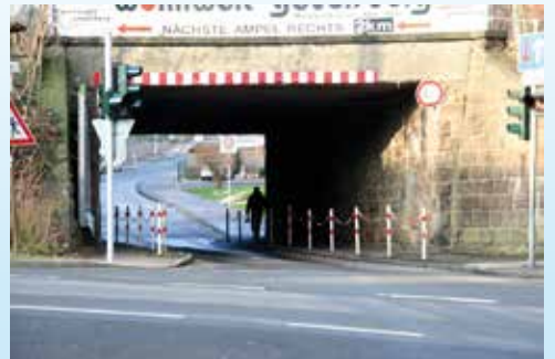
Brücke der Rheinischen Bahn über die Linderhauser Straße in Schwelm. Diese Brücke soll im Zuge des Ausbaus des Kreuzungsbereichs Linderhauser/ Hattinger Straße abgebrochen werden.
