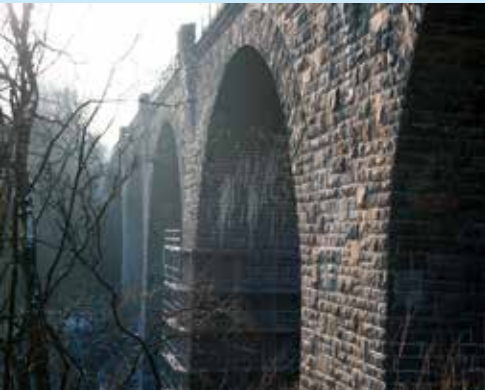
Das Viadukt von Wengern, über das der Radweg geführt wird
