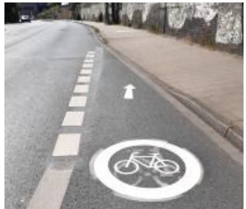
Mai 2020: Fahrradsymbol und Pfeil, der ausschließlich auf den Gehweg zeigt, wurden erneuert.
