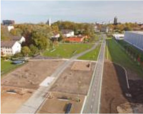
Abschnitt A4 ist bereits fertig (Foto Stadt Bochum)
