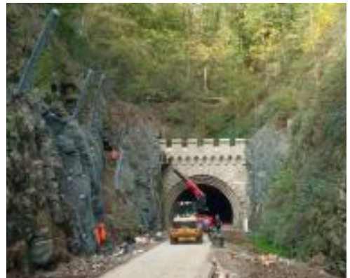
Aufwendige Hangsicherungsarbeiten, leider mit Verlusten an Geotopen
