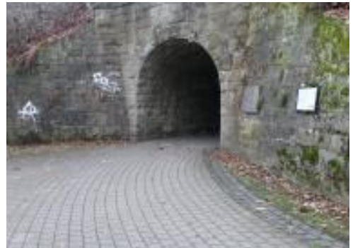
Mittellinie mit Pfeilen zum Rechtsfahren erforderlich
