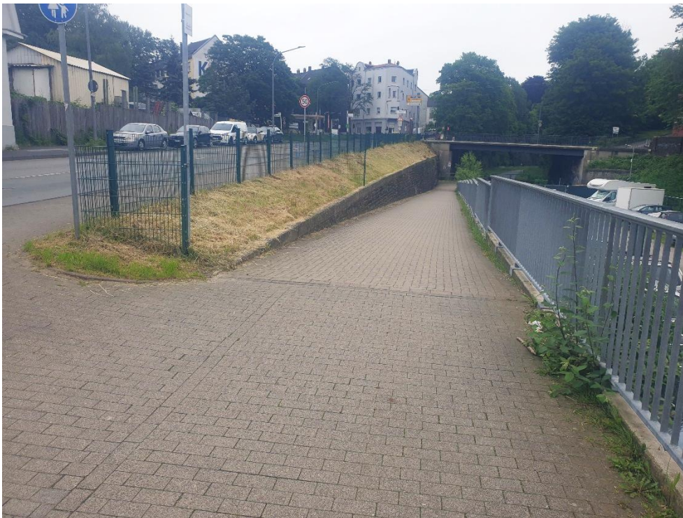
Bild 9: Engstelle der Bergisch-Märkischen Veloroute in Wuppertal (Quelle: eigenes Foto)
