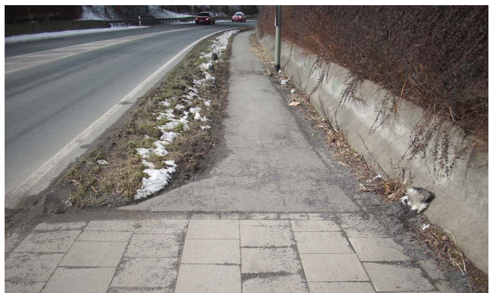
Blankensteiner Straße L 924: Schmaler Asphaltweg
