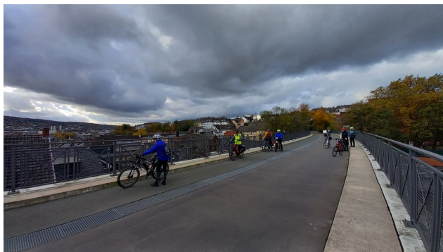
Nordbahntrasse Kuhler Viadukt
