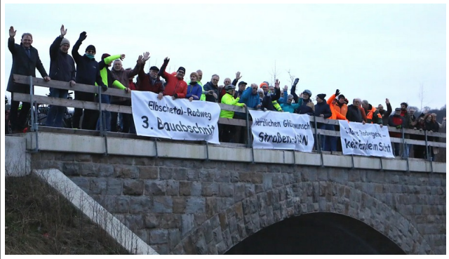
Bauabschnitt 3 der Elbschebahn
